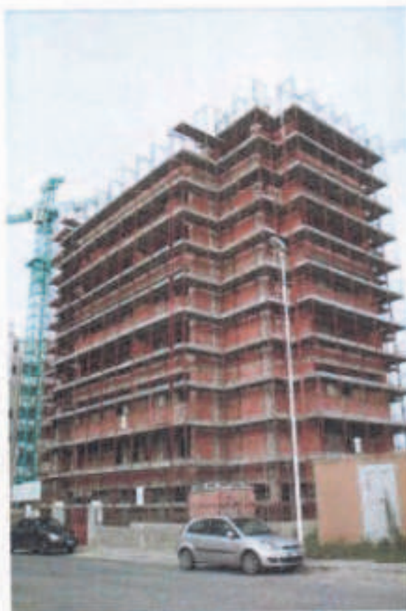
Nuova costruzione strada B
