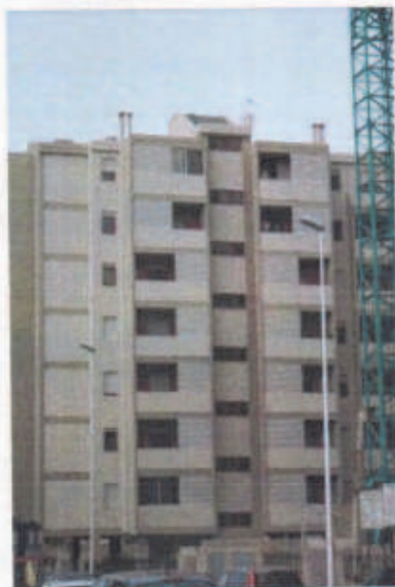
Costruzione presso strada D
