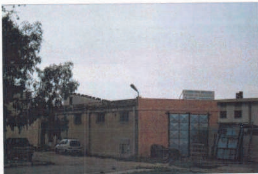
Carpenteria fine strada L
